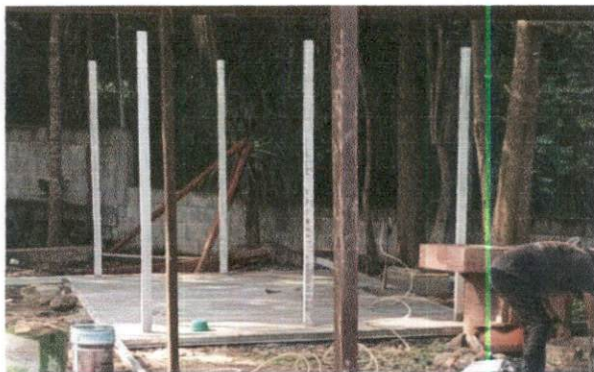
Foto 3: AVANCE EN GALERA
