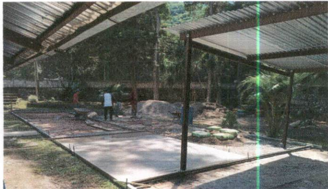
Foto1: TRABAJO EN CANCHA DEL ESTABLECIMIENTO
