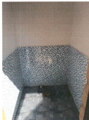
Foto 2: COLOCACIÓN DE PISOS Y AZULEJOS EN BAÑOS
